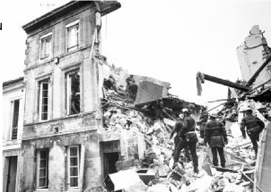
Explosion rue Laroche à Bordeaux 1 décès, 2 BBB
